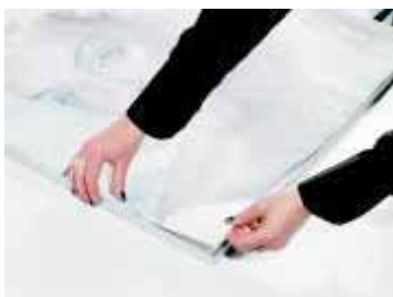
Stofftuch mit dem Gummikeder in die Nut des Profils drücken
